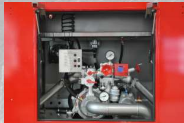
Установка насоса и трубопроводов
